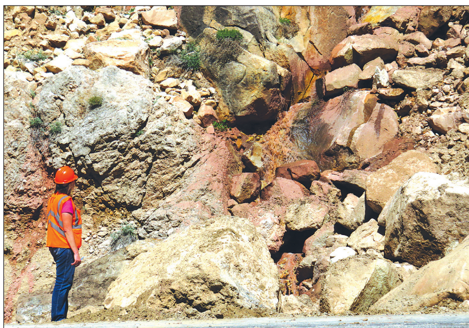
photo courtesy of WYDOT
